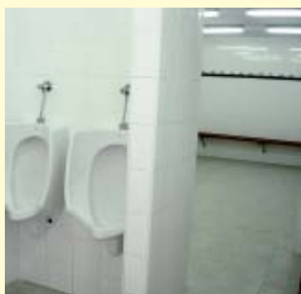
Els vestidors del camp d'esports han estat reformats completament.
