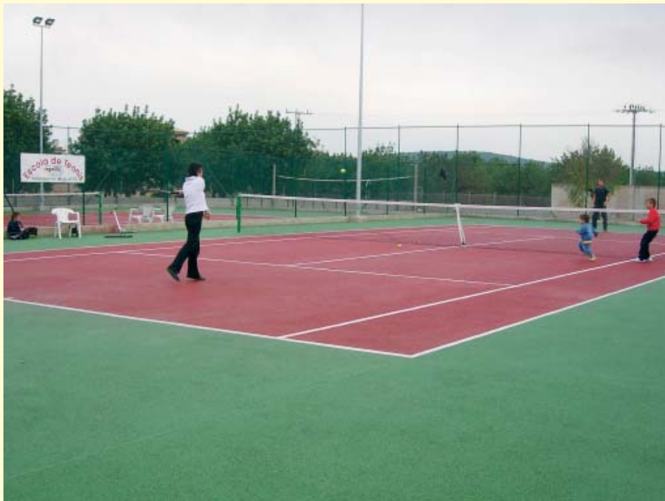
Imatge d'una de les pistes de tennis construïdes per l'Ajuntament.
