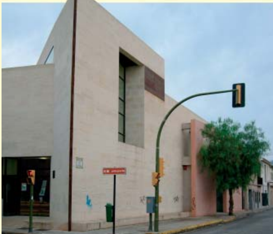
L'edifici municipal de Ses Cases des Mestres ja està climatitzat.
